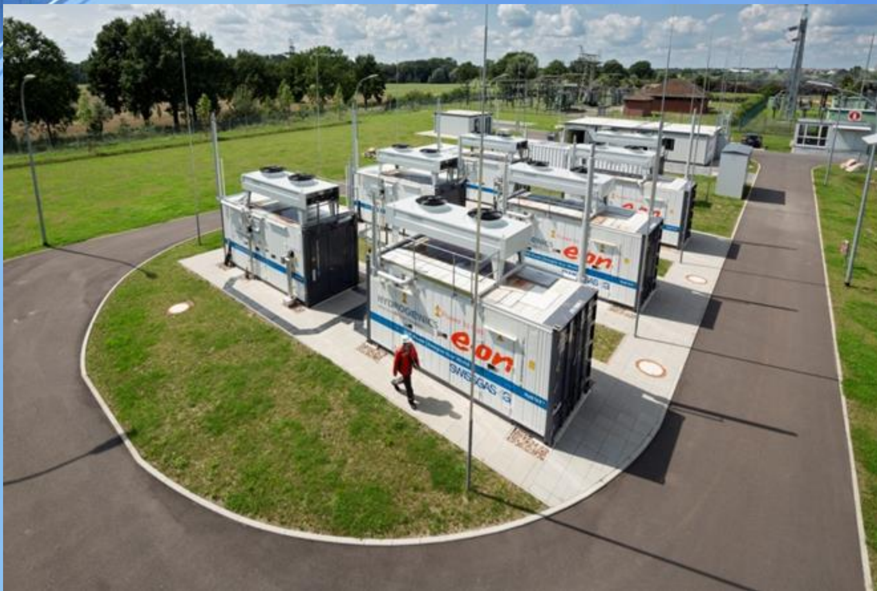
Fot. 1. Instalacja elektrolizerów w Falkenhagen, Niemcy (źr. E.ON)
