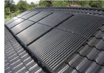
Kolektory słoneczne dla zbiornika lodu
